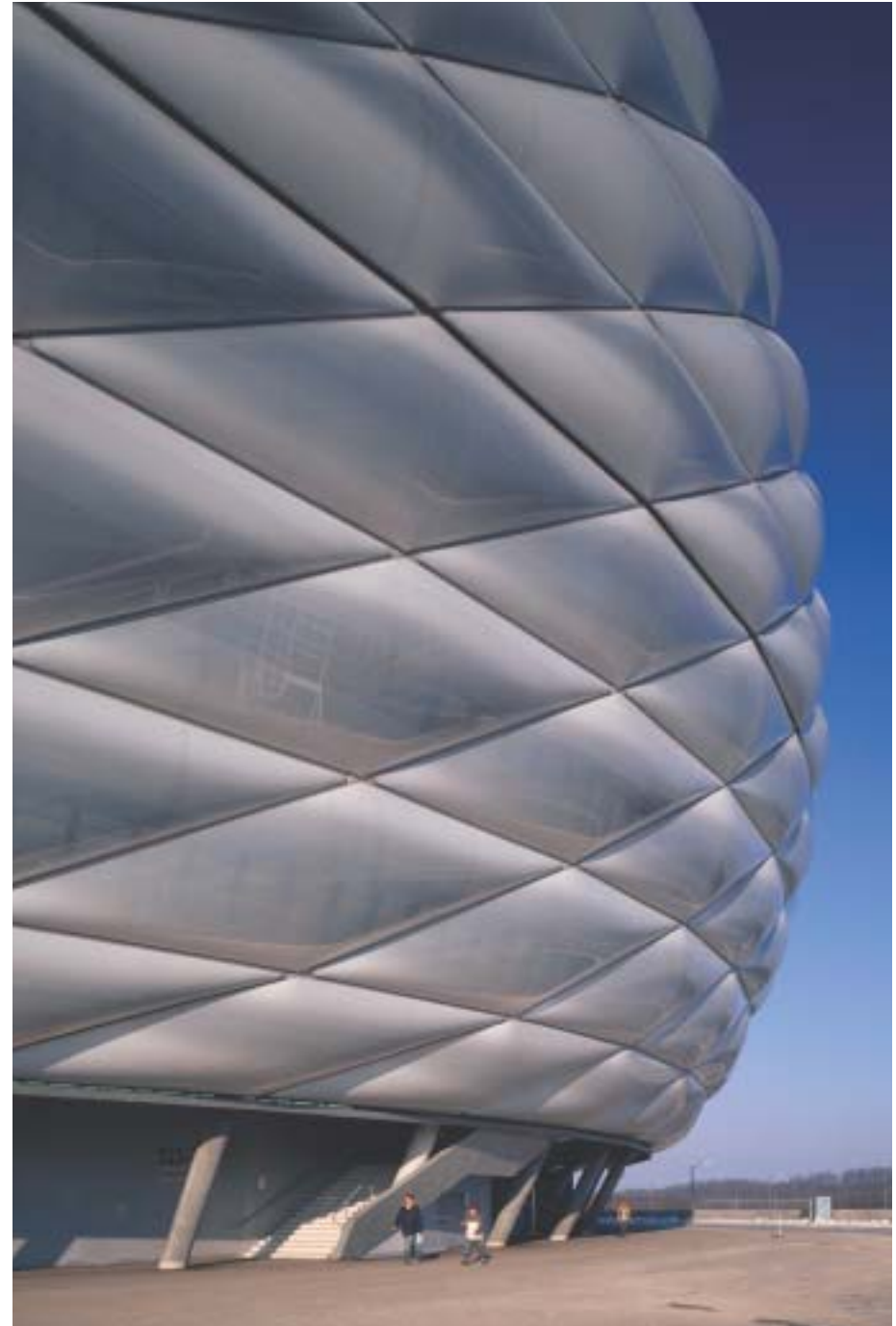
Une enveloppe faite de coussins d'air sous pression en polymère ETFE. Stade Allianz Arena à Munich, Herzog & de Meuron.
