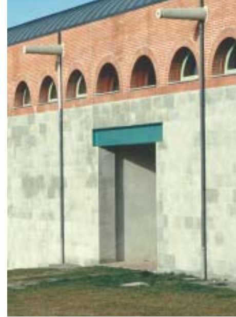
Arcs en briques et linteau d'acier se superposent. Centre d'art de Vassivière (87), Aldo Rossi et Xavier Fabre.
