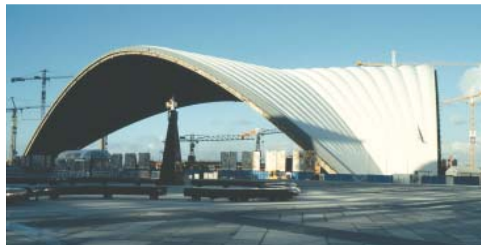
La coque en béton du CNIT lors de sa rénovation. CNIT, Paris-La Défense, Bernard Zehruss.
