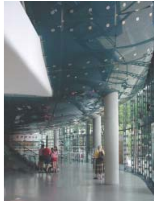
Une peau en plaques de verre cintrées sépare le hall des salles d'exposition en étage. Kunsthau à Graz (Autriche), Peter Cook.
