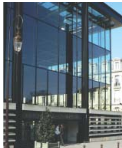
La structure porteuse en acier permet une transparence de l'enveloppe. Médiathèque à Reims (51), Jean-Paul Viguier.
