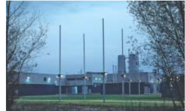
Des équipements techniques au service de la ville. Usine de traitement des eaux à Begles (33), Jean de Giacinto.
