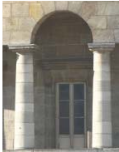
Les claveaux de pierre taillée reposent sur des colonnes. Rotonde de la Villette à Paris, Claude-Nicolas Ledoux.
