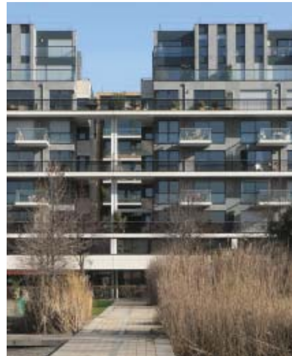
Réinterprétation contemporaine des trois séquences principales. Immeuble de logements sur le parc de Bercy à Paris, Jean-Pierre Buffi.
