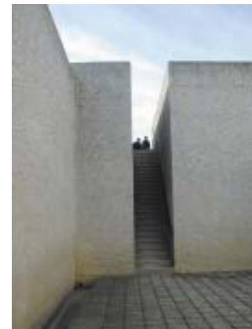
Une rampe établit la liaison entre des plateaux superposés. Centre national de la Danse à Pantin (93), Jacques Kalisz et reconversion par Antoinette Robain et Claire Guieysse
